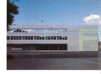
hen aus vorfabrizierten Betonelementen. Die tragenden Aussenwände sind durchgehend als Zweischalenmauerwerk aufgebaut, die äussere Schale in Sichtbeton. Die Werkstätten sowie die Fahrzeughalle werden im Innern geprägt durch die an Wänden und Decken offen geführte Haustechnik. Im Bürotrakt (um die unterschiedliche Funktion dieses Gebäudes hervorzuheben) ist dieses unsichtbar und verbirgt sich hinter den Sichtbetonflächen.
