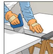
3. Innen-Dämmplatten mit einer Säge zuschneiden.
