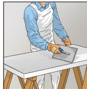
5. Kleber vollflächig mit Zahnpachtel/Zahnkelle auf die Innen-Dämmplatte aufkämmen (10 mm Zahnung/C5).
