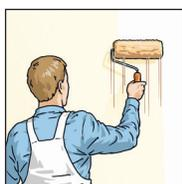
9. Innen-Dämmplatte mit Kleister grundieren.
