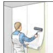
9. Klimaplatten sind ohne Armierung mit allen diffusionsoffenen Wandbelägen, Putze und Beschichtungsstoffe etc. überarbeitbar.
